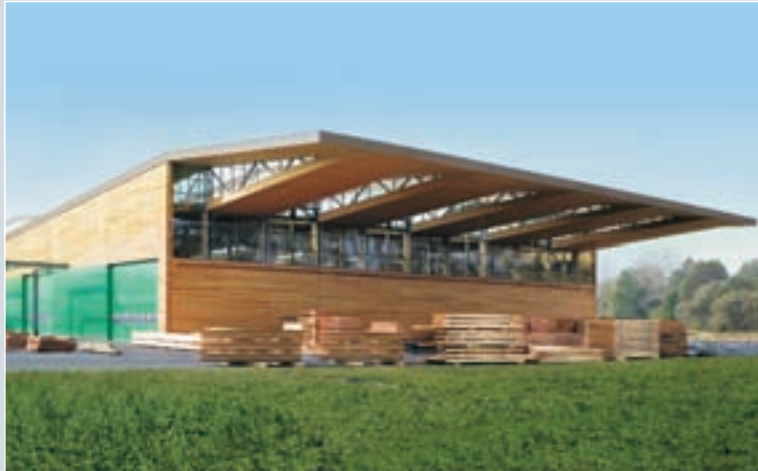
Produktionshalle Obermayr Schwanenstadt (Bauherrenpreis 2006, OÖ Holzbaupreis 2007)
