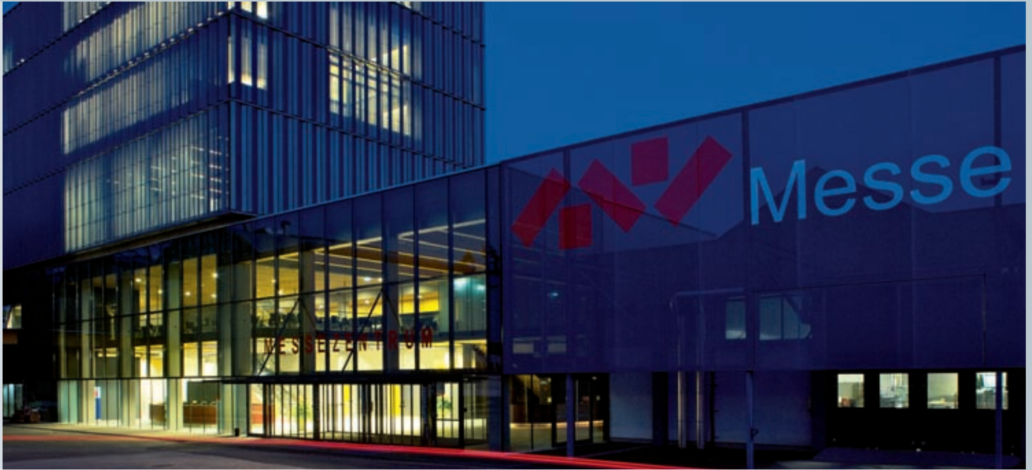
Das Messezentrum Neu setzt den Erfolgskurs der Messe Wels auch in Zukunft fort und wird als nationaler und internationaler Messestandort dienen.
