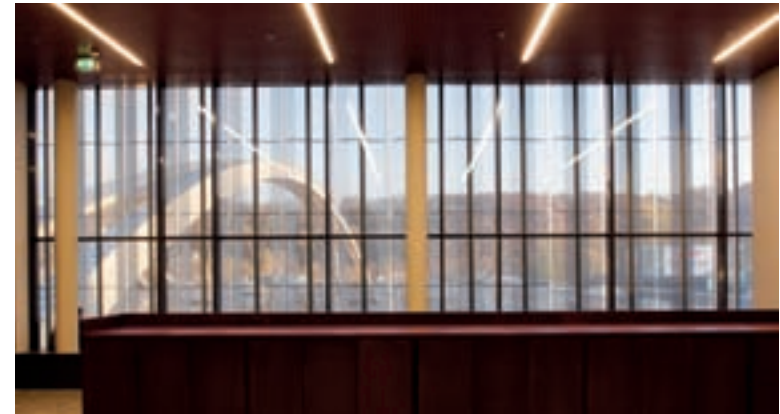
Hohe Energieeffizienz durch 3-Scheiben-Isolierverglasung und Lamellenvorhänge
