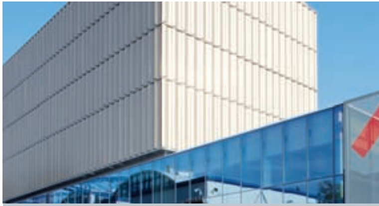
Außen angebrachte, individuell steuerbare Lamellenvorhänge
