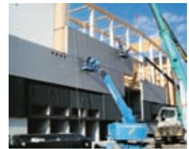
Fassade Halle F
