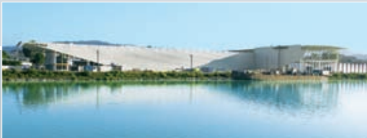
Referenzen in allen Bereichen des Hoch- und Ingenieurbaus, wie z.B. das voestalpine Stahl Service Center Linz
