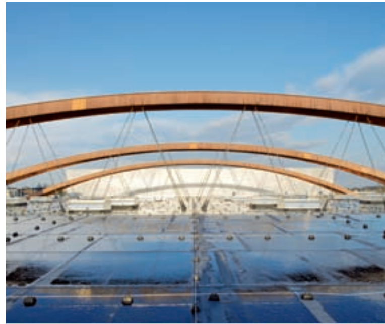
Drei Bogentragwerke aus Brettschichtholz
