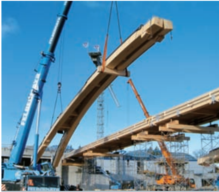
Bogenträger setzen
