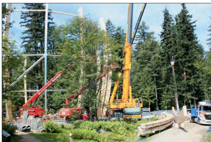
Unten: Ein- heben der Bögen im unteren Turm- abschnitt
