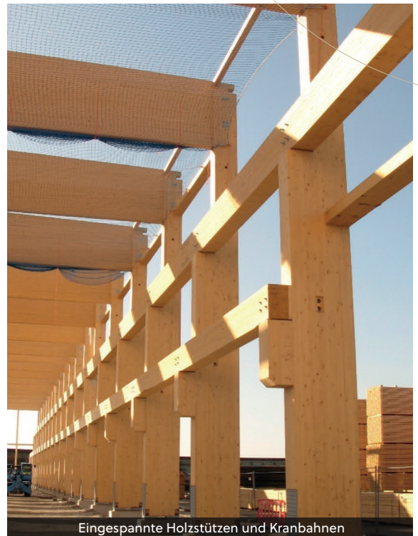
Eingespannte Holzstützen und Kranbahnen
