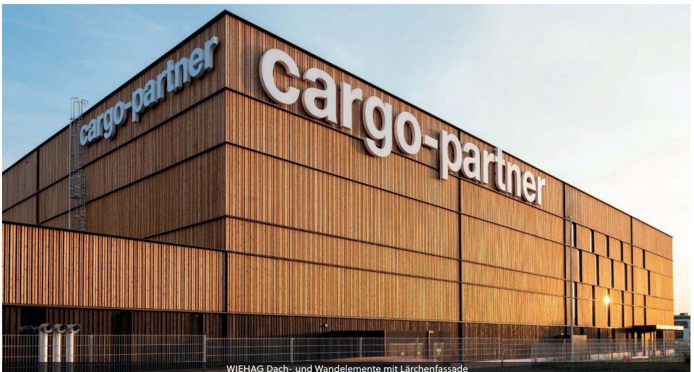
WIEHAG Dach- und Wandelemente mit Lärchenfassade
