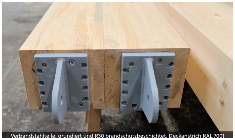
Verbandstahlteile, grundiert und R30 brandschutzbeschichtet, Deckanstrich RAL 7001
